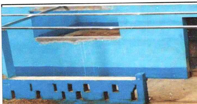
Foto 5: mantenimiento de ventanas previo a la colocación para una fabricación nueva
