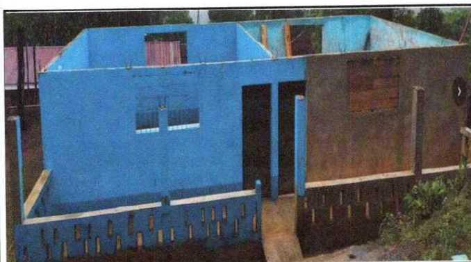
Foto 3: Desmontaje de láminas para su destitución por láminas troquelada Módulo 2
