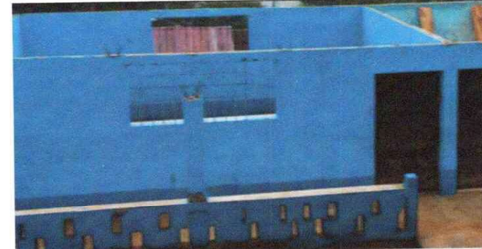
Foto 6: Mantenimiento de ventana previo a la colocación con marco angular
