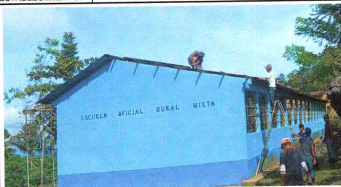
Foto 1: Desmontaje de láminas para su destitución por laminas troquelada Módulo 1
