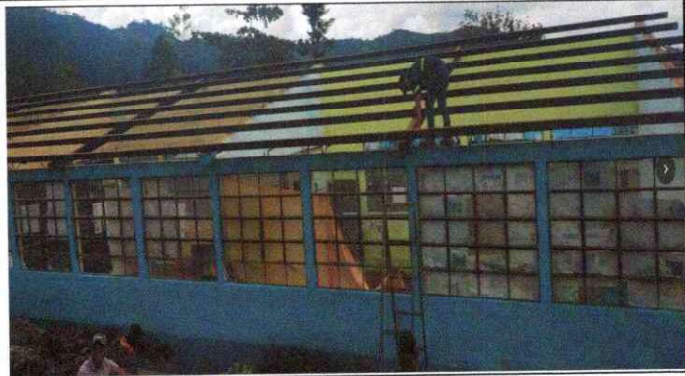
Foto 2: Mantenimiento de estructura de soporte Módulo 1
